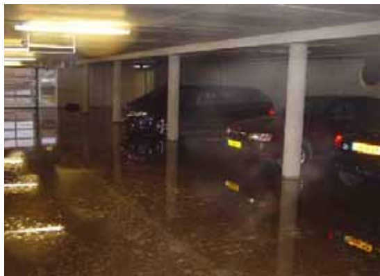
schadebeeld: Nijmegen, wateroverlast door verdichting bodem bij aanleg van Limosterrein
