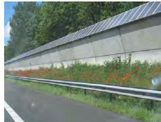
inspiratie: A10, zonnepanelen op geluidsscherm
