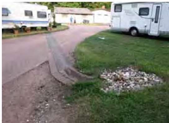
inspiratie: Keulen, zichtbaar infiltreren van regenwater
